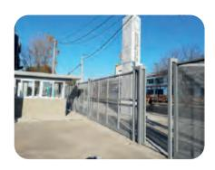
Se ejecutó la totalidad de la obra que permite la integración del acceso principal de la Universidad con los edificios y las circulaciones internas, consistió en la construcción del piso de hormigón para vehículos, un solado de baldosas táctiles y un solado de bloques intertrabados de hormigón para el estacionamiento de motos y bicicletas.
